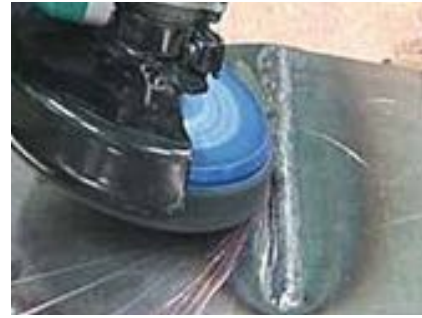
Entfernen von Verfärbungen
